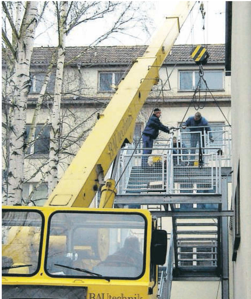
Zweiter Fluchtweg: Gestern wurde die stählerne Außentreppe an den BBS-Anbau mit dem neuen Hauswirtschaftskabinett montiert. Foto: René Beuckert
